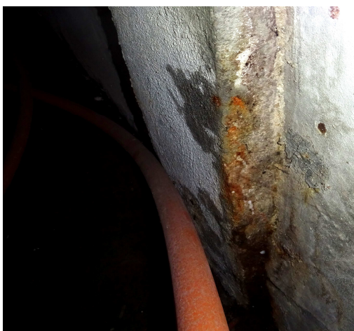
Pracovní spára v 1.PP mezi armaturní komorou a šachtou
