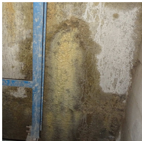
Plošný průsak v 1PP s výronem bahna
