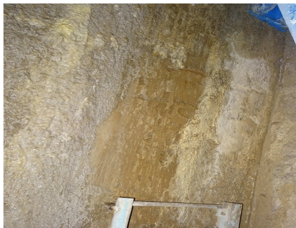
Plošný průsak v zadní stěně lezního oddělení
