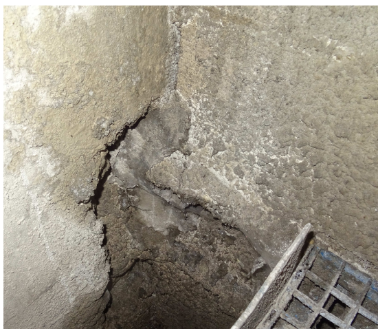
Průsak v místě osazení nosníku do ostění
