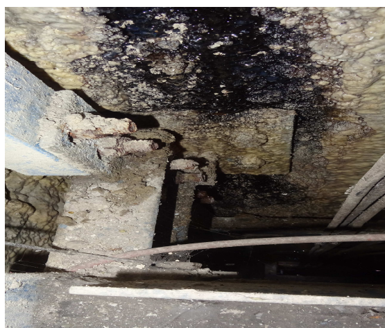
Průsak v místě osazení nosníku do ostění a průsak nad osazením nosníku degradací betonu 3.PP
