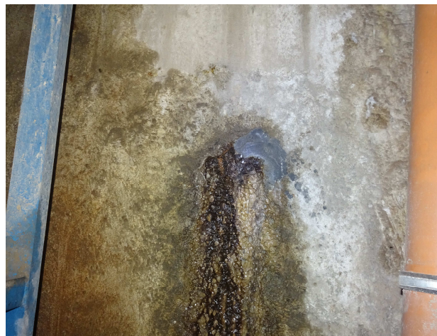
Průsak hloubkovou degradací ostění v 5.PP
